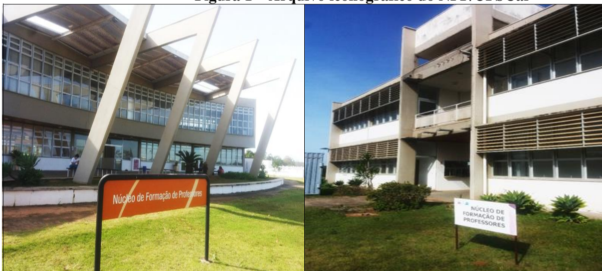
Fachada frontal A B Área dos fundos
